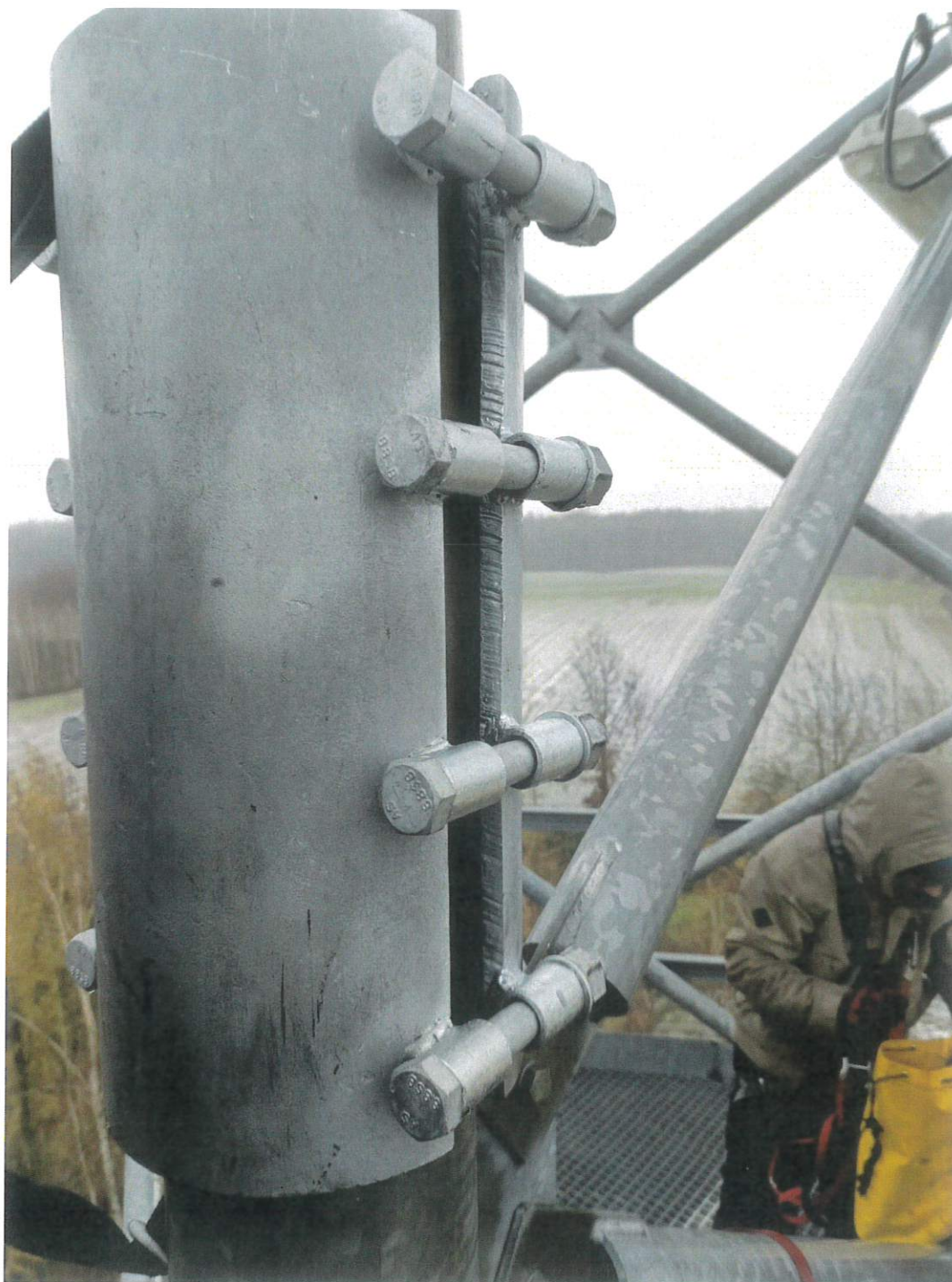
Fot. 11. Zabezpieczenie krawężnika łubkami
