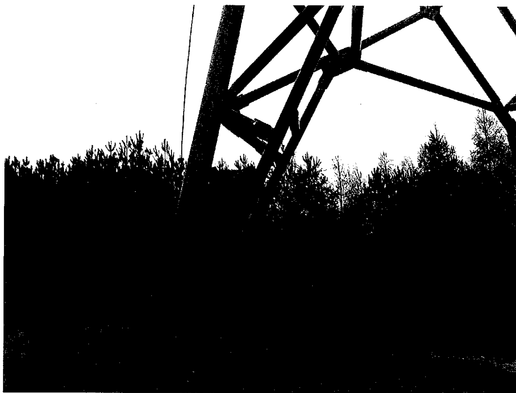
Fot. 3. Skratowanie dolnej części krawężnika
