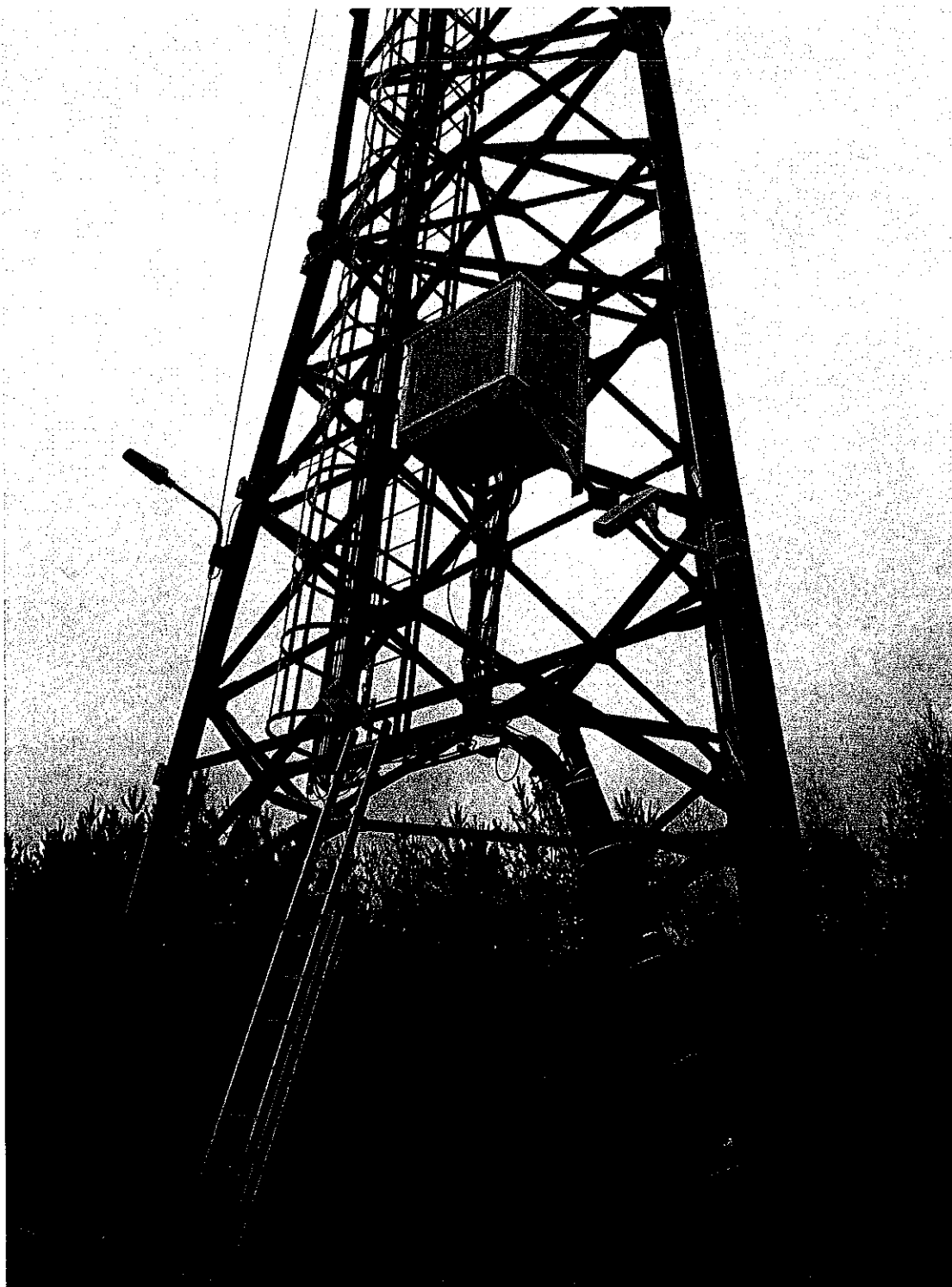
Fot. 2. Segment dolny wieży
