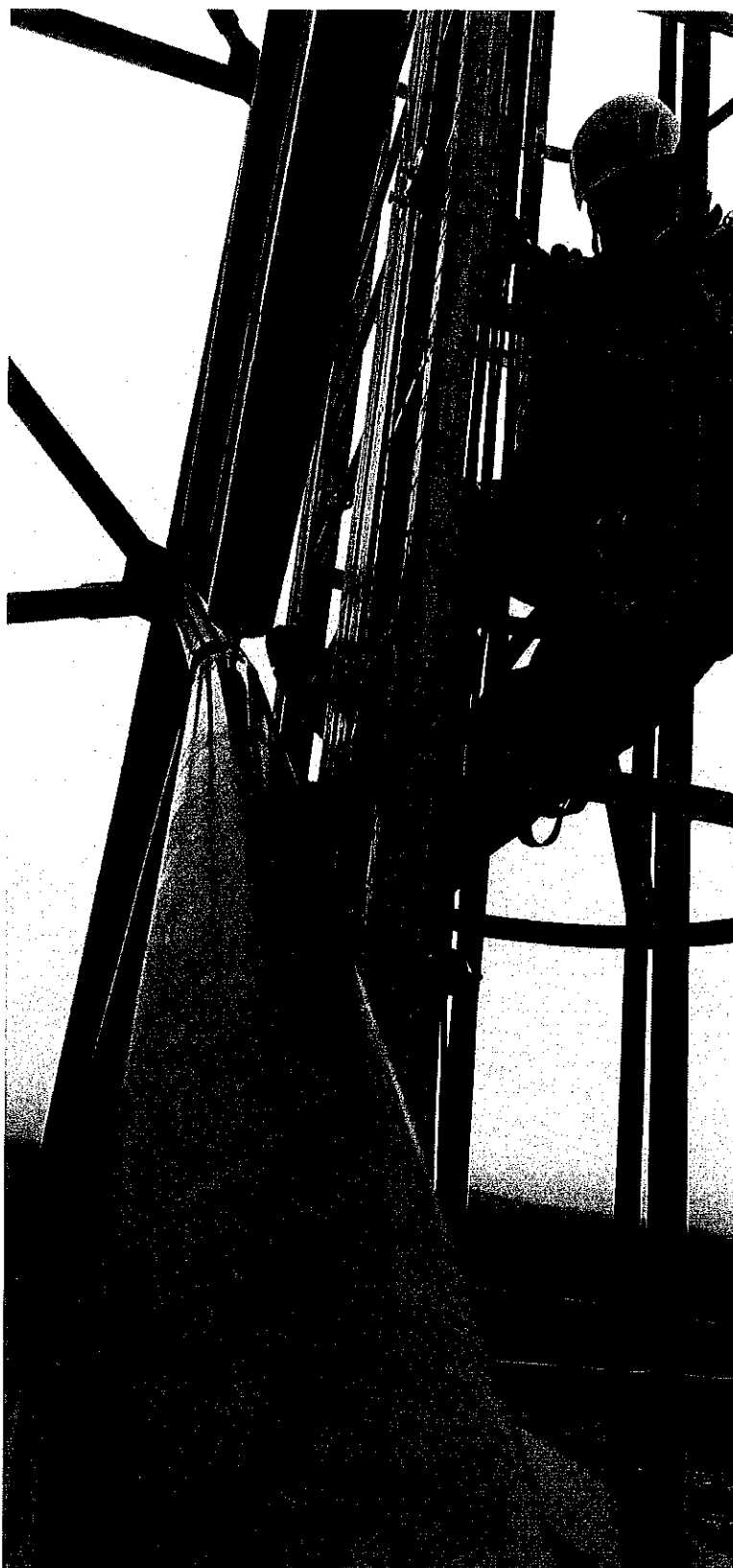
Fot. 14. Skratowanie odkształcone z płaszczyzny
